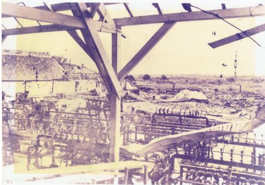
Gambar 1. Kerusakan setelah peristiwa Bandung Lautan Api
