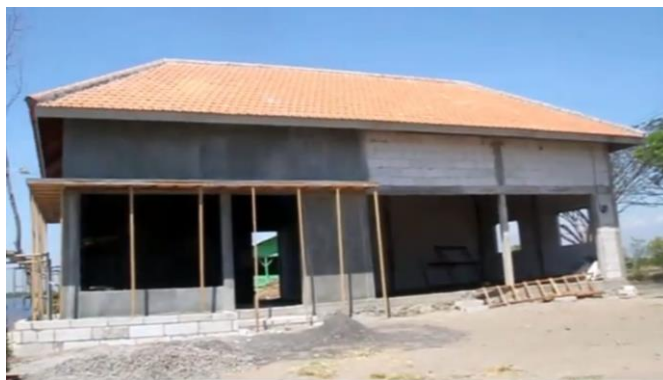
Gambar 2. Pembangunan Ruko PKL
