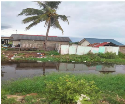
Gambar 1. Kondisi Pantai Alue Naga
