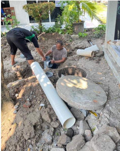
Gambar 5. Pemasangan PRH
