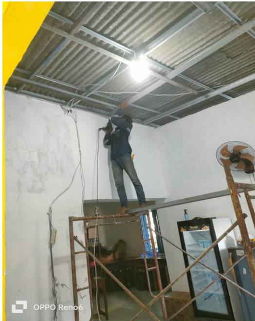
Gambar 6. Proses Pekerjaan Instalasi Kelistrikan Pada Area Sekolah.
