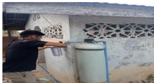
Gambar 2. Pemasangan alat penyaringan/filter air bersih di lingkungan Masjid Desa Pahlawan.
