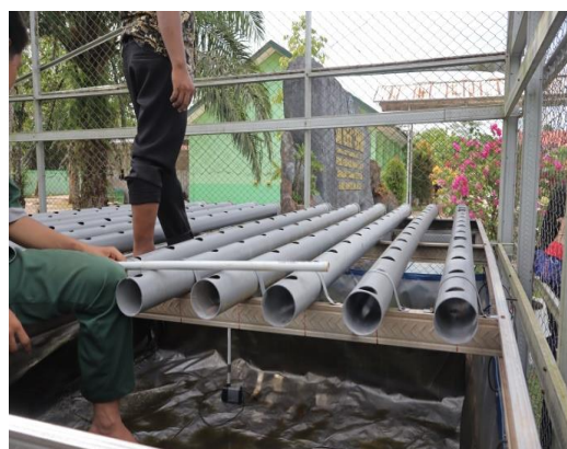
Gambar 8. Proses Pemasangan Pipa Aquaponik
