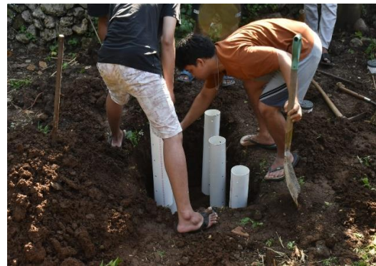
Gambar 2. Pengecekan lebar dan kedalaman tanah untuk Lubang Resapan Biopori
