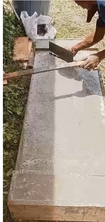
Gambar 10 : Pengecoran Pelat Beton
