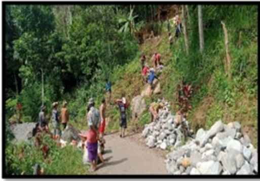
Gambar 3: Pembangunan Pondasi Penahan Longsor
