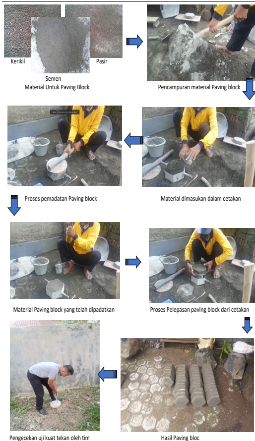
Gambar 1. Proses produksi Paving Block
