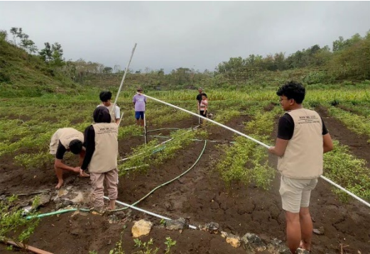
Gambar 1. Instalasi Sprinkler Semi Otomatis di Lahan Cabai
