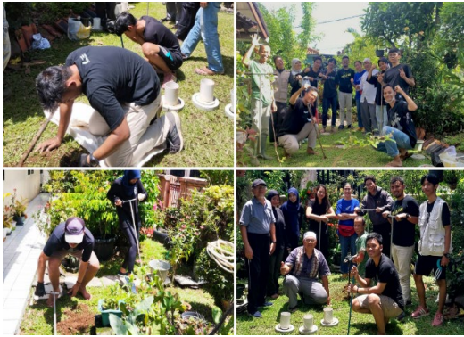
Gambar 9. Pembuatan Lubang Resapan Biopori di taman Ibu Lina (Sumber: Dokumen Pribadi)
