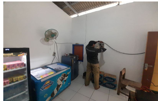
Gambar 2. Pemasangan Sistem PLTS
