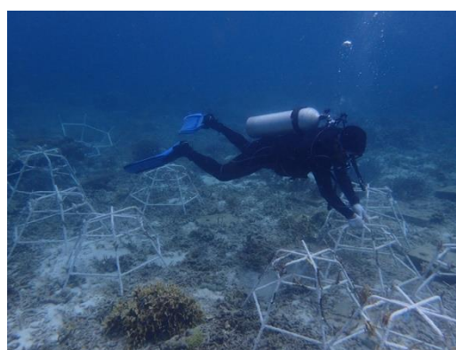
Gambar 6 Proses penurunan rangka
