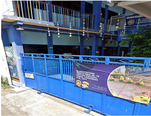
Gambar 1: Profil Gedung TK Aisyiyah Bustanul Athfal (ABA) 1 Gedangan
