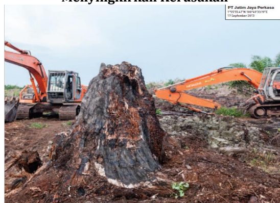
Gambar 3. Pekerja PT Jatim Jaya Perkasa Menyingkirkan Kerusakan
