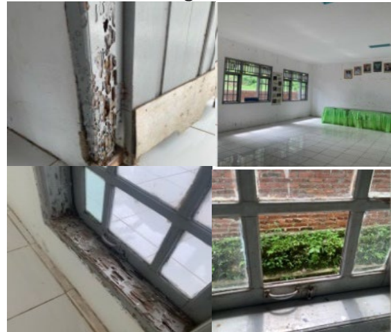
Gambar.3 Gedung Kelurahan Kedaung
