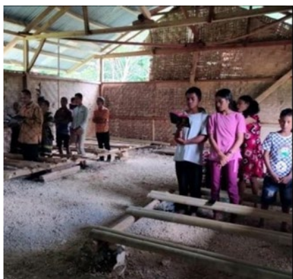
Gambar 6. Bangunan Gereja yang tidak layak
