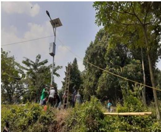
**Gambar 6. Pemasangan Tiang Lampu Solar Panel**
