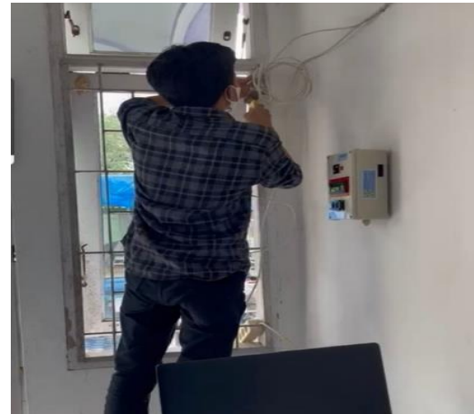
Gambar 6 Pemasangan perangkat pendukung
