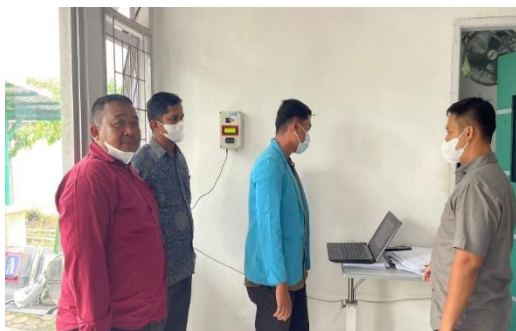
Gambar 5. Tim Pengabdian melakukan pemasangan alat
