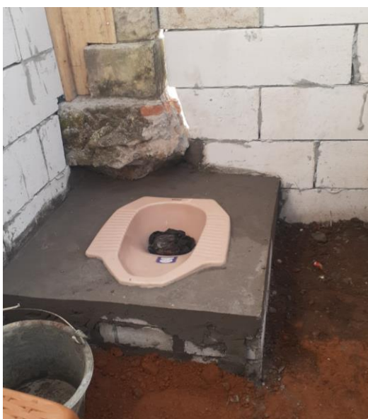
Gambar 1. Pembangunan Jamban Sehat
