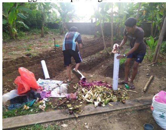
Gambar 4. Sampah Organik Tangga dan Proses Memasukkan Sampah ke LRB
