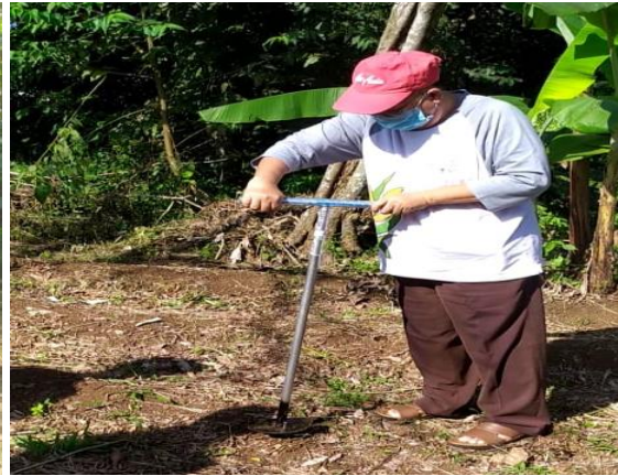
Gambar 3. Penentuan Titik LRB dan Pembuatan LRB menggunakan bor
