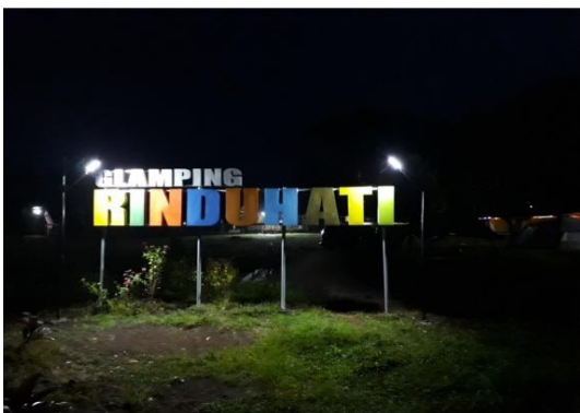
Gambar 6. Pemasangan penerangan berbasis panel surya dan perangkat yang terpasang
