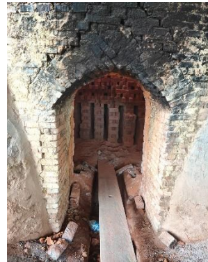
Gambar 1: Proses Pemanggangan Batu Bata di Bangsal Bapak Zulkifli (Dok. Survei Awal, 2021)
