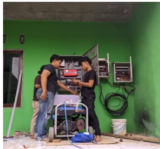
Gambar 10. Pemasangan Sistem Kontrol
