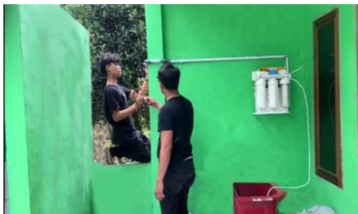
Gambar 12. Pemasangan Instalasi RO
