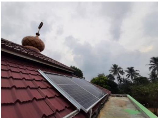
Gambar 8. Pemasangan Panel pada Rooftop Masjid
