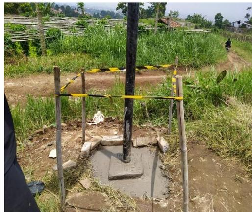
**Gambar 3 : Pemasangan Tiang PJU Solar Cell**
