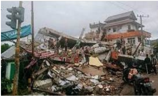
Gambar 2. Kondisi Bangunan pasca gempa di Sulbar
