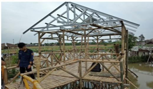
Gambar 4. Pembangunan Rangka Baja PLTS
