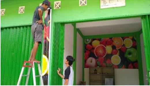
Gambar 8. Proses Pemasangan Wallpaper Dinding Bagian Luar
