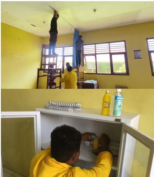
Gambar 3. Pemasangan ruang UKS (atas) dan penataan obat-obatan dan BMHP (bawah)
