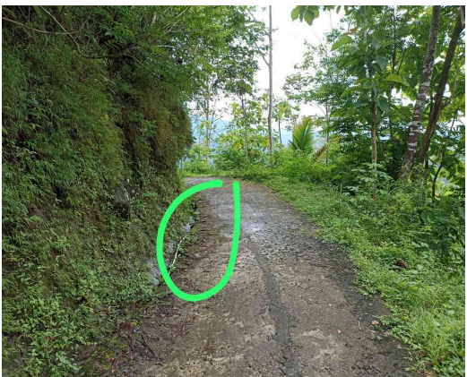
Gambar 4. Jaringan pipa yang melewati area
