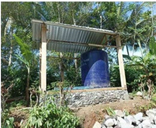
Gambar 11. Hasil pembangunan reservoir kapasitas 5000 liter pada 17 April 2022
