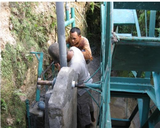
**Gambar 6. Pemasangan Pompa di Lokasi**
