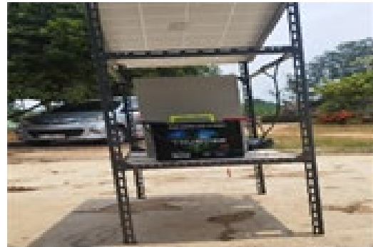
Gambar 2. Pemasangan Panel Box
