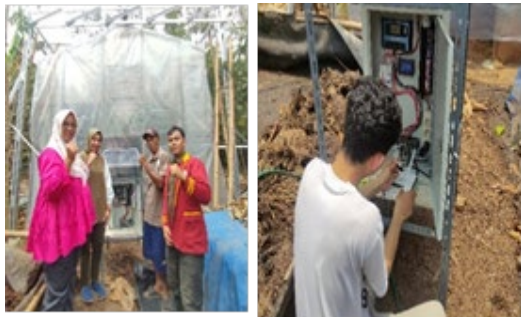
Gambar 4. Pemasangan Mikrokontroler ke Box Panel
