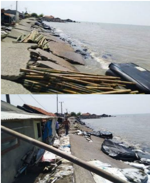
Gambar 1. Kondisi eksisting di pinggir Pantai Cemarajaya
