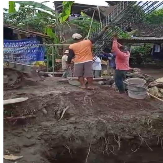
Gambar 15. Pembesian Kolom
